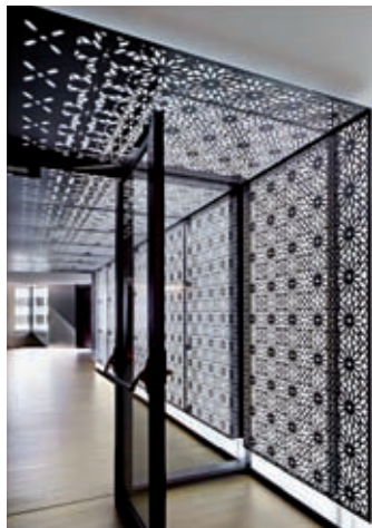
Figura 5.9. Paneles realizados mediante cortadora láser
